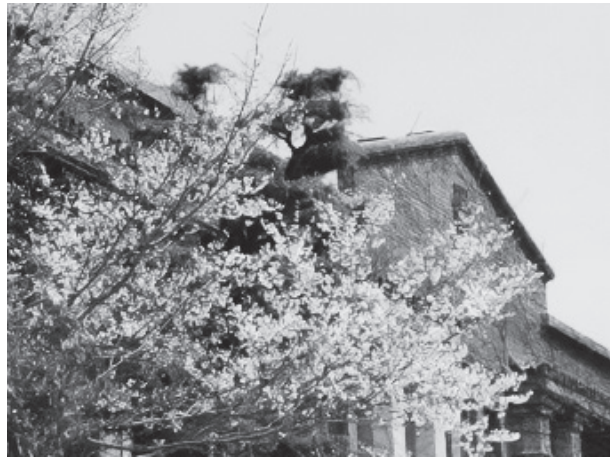
図 17 変わらない毎年入学式に開花する桜 本部棟正面玄関
