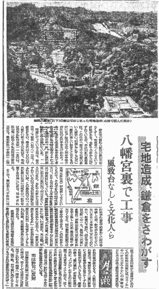
図表記事2-2 読売新聞 「宅地造成、鎌倉を騒がす八幡宮裏で工事」
